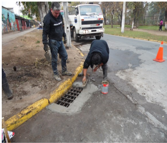
Instalación de rejillas El Estero y Las Colinas
