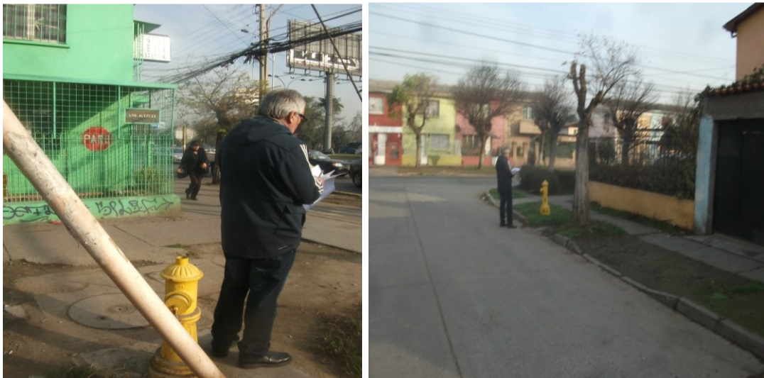
Trabajo comunitario catastro de estado de grifos
