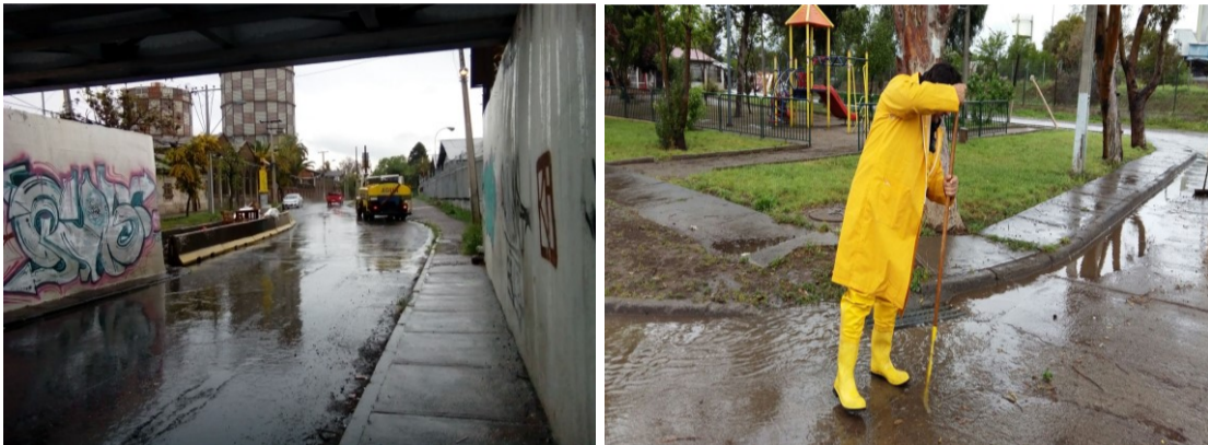
Operativo preventivo de limpieza y habilitación de sumideros
