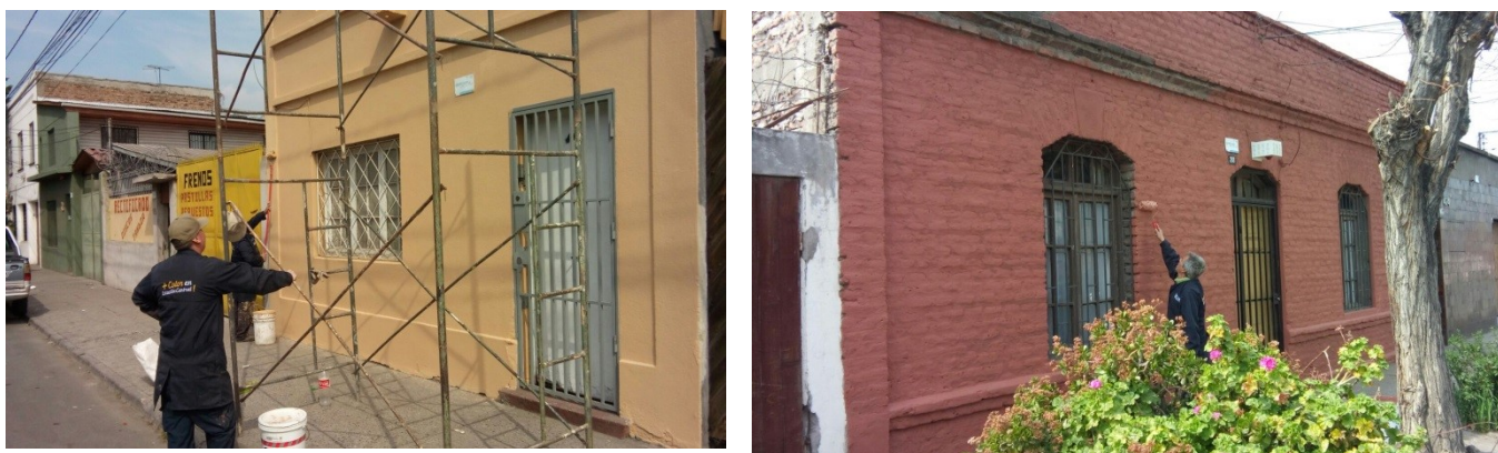
Pintura de fachadas
