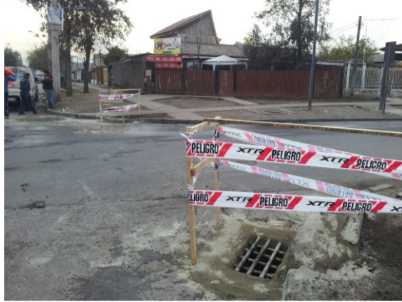
Instalación de rejillas de sumideros en Luis Infante Cerda y Las Estepas
