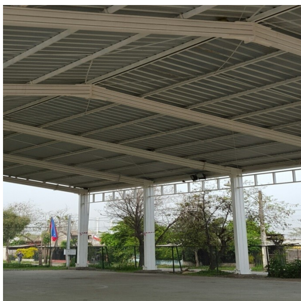
Techado de Multicancha
